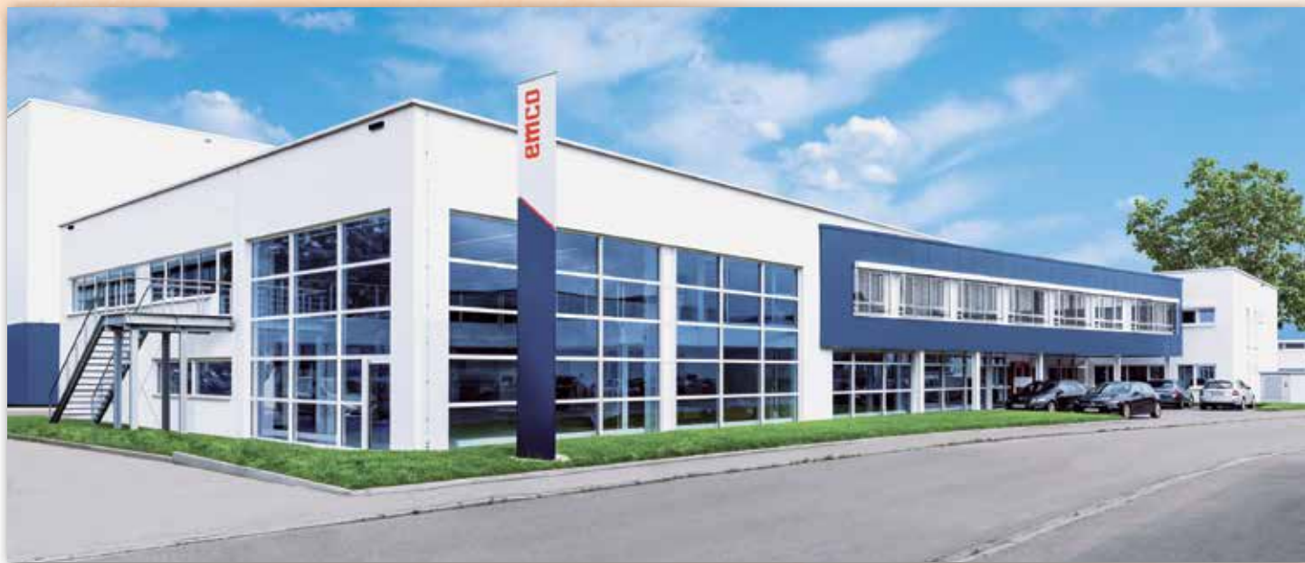
Pohled zvenčí na nové technologické centrum EMCO
