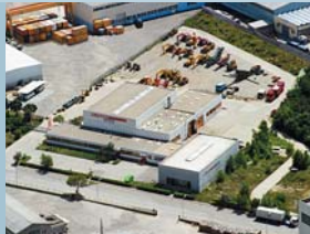
KUHN Servicewerk Baumaschinen Himberg/Wien A-2325 Himberg Rauchenwartherstraße 4 Telefon: +43 (0)2235 / 875 80 Telefax: +43 (0)2235 / 875 80-491 E-mail: office-bm@kuhn.at
